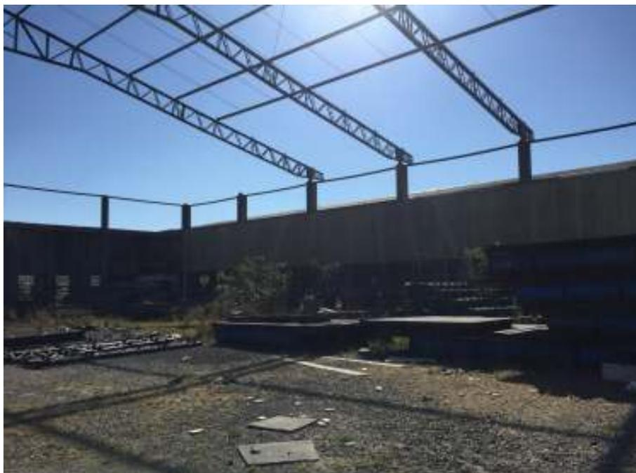
**Estrutura parcialmente montada, faltando tesouras, terças, mãos-francesas, estabilizadores, contraventamentos. As peças estão depositadas no solo.**
